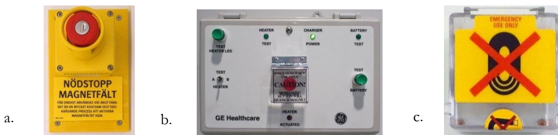
Figur 8. Nödstopp/quenchknapp för magnetfältet för tre olika leverantörer av utrustningar. a) Philips, b. GE och c) Siemens.
