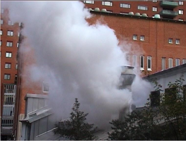
Figur 9. Quench. Heliumgas strömmar ut ur quenchröret på taket.
